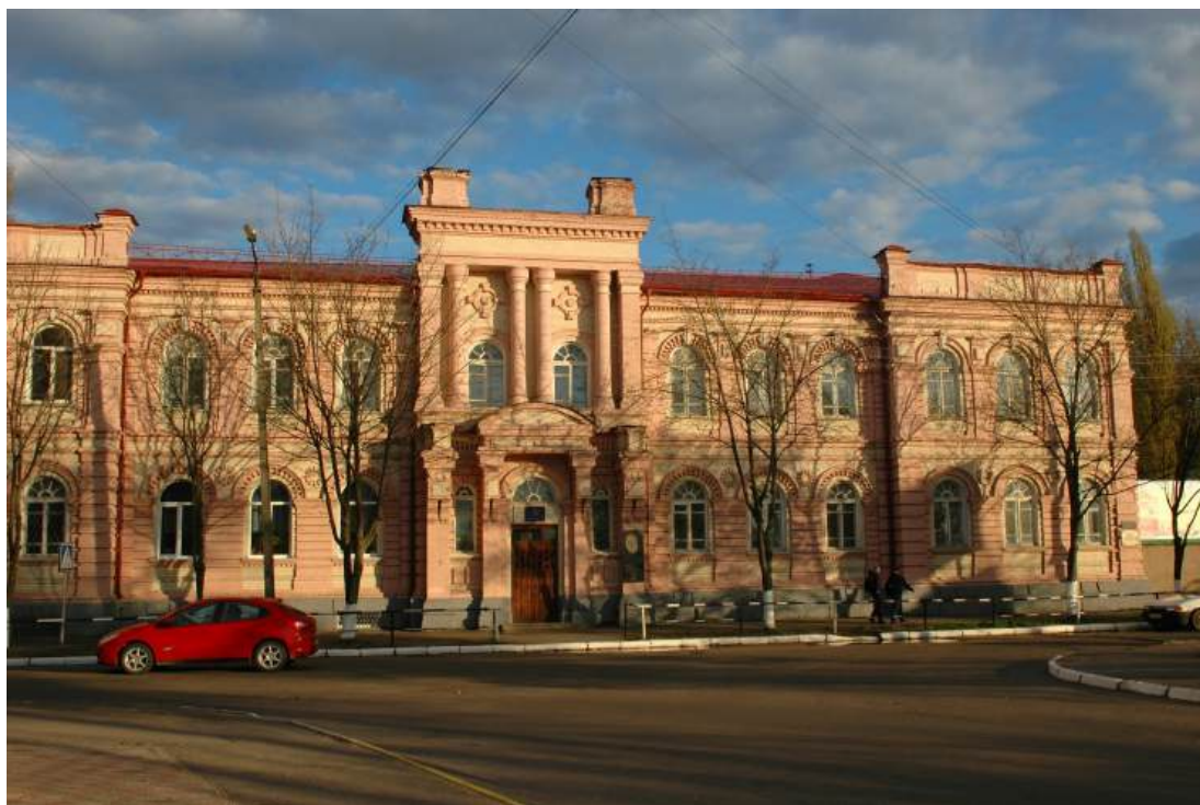
Рис. 1 Фото фасаду будівлі Професійно-технічного училища №26, вул. Сержанта Мельничука, 4.
